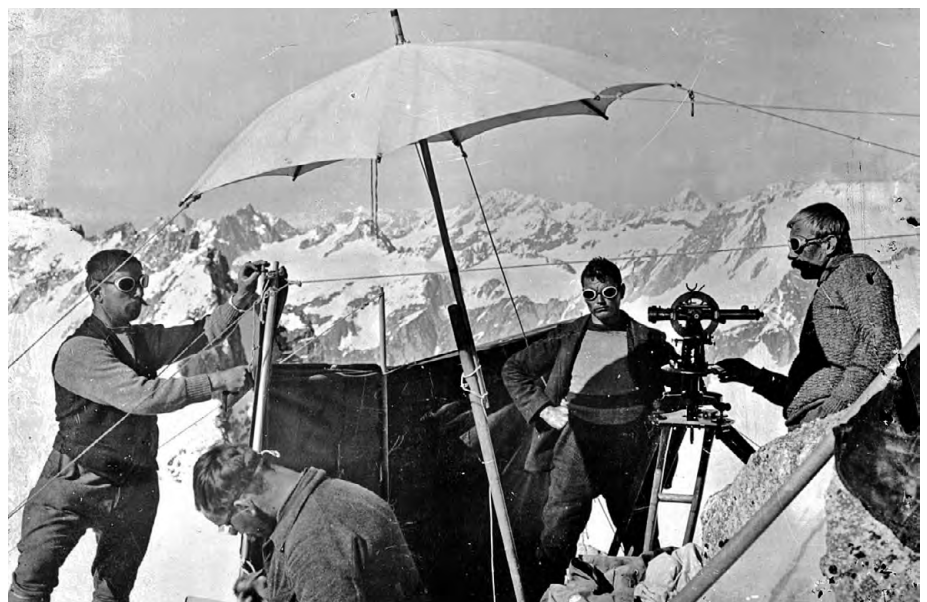
Abb. 2: Ingenieure bei der Triangulation 1. Ord. (LV03) auf TP «Cima della Bondasca» GR, 1916 (Foto: swisstopo).
