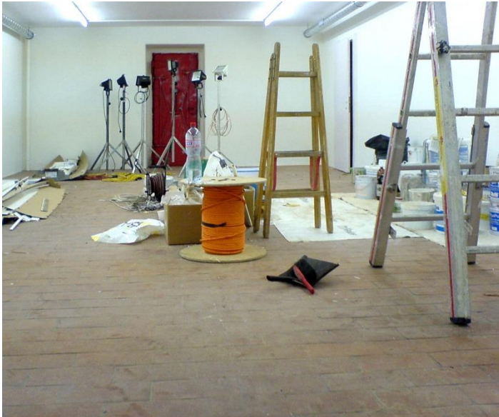
Renovation der ehemaligen Zivilschutzanlage 2009
