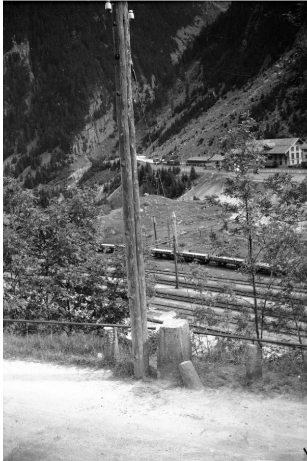
Abb. 7: (alter) Axpfeiler Nord von Gelpke in Göschenen, 1938 von H. Zölly als 'Top. Punkt 107 Gö' senkrecht gestellt (swisstopo Bild 5546c, 1938)
