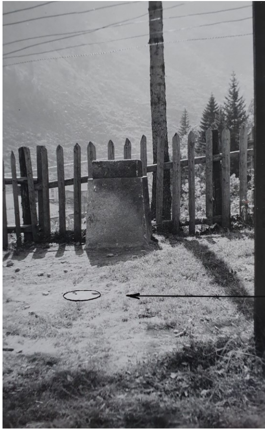
Abb. 8: Gelpkes «Göschene neu III» (links, bodeneben) und Koppes astronomischer Pfeiler 1874, von H. Zölly im Areal des Bahndienstgebäudes neu versetzt (swisstopo Bilder 5545a, 5545c, 1938)
