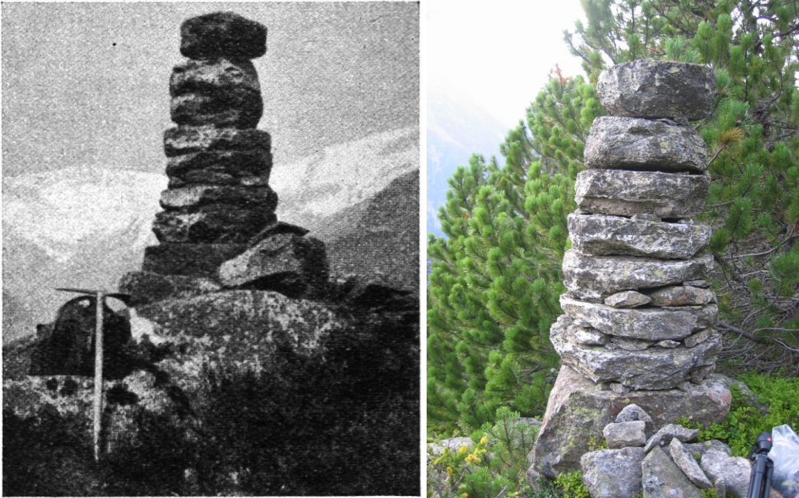
Abb. 17: Messpfeiler Rienzerstockgrat von Gelpke, Zustand 1931 und 2009. Das Instrument wird links auf der zweitobersten Platte zentrisch aufgestellt (Zölly 1940c, S. 24) und (D. Mauro, 2009)
