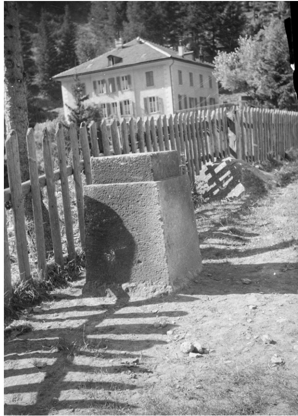
Abb. 8: Gelpkes «Göschene neu III» (links, bodeneben) und Koppes astronomischer Pfeiler 1874, von H. Zölly im Areal des Bahndienstgebäudes neu versetzt (swisstopo Bilder 5545a, 5545c, 1938)
