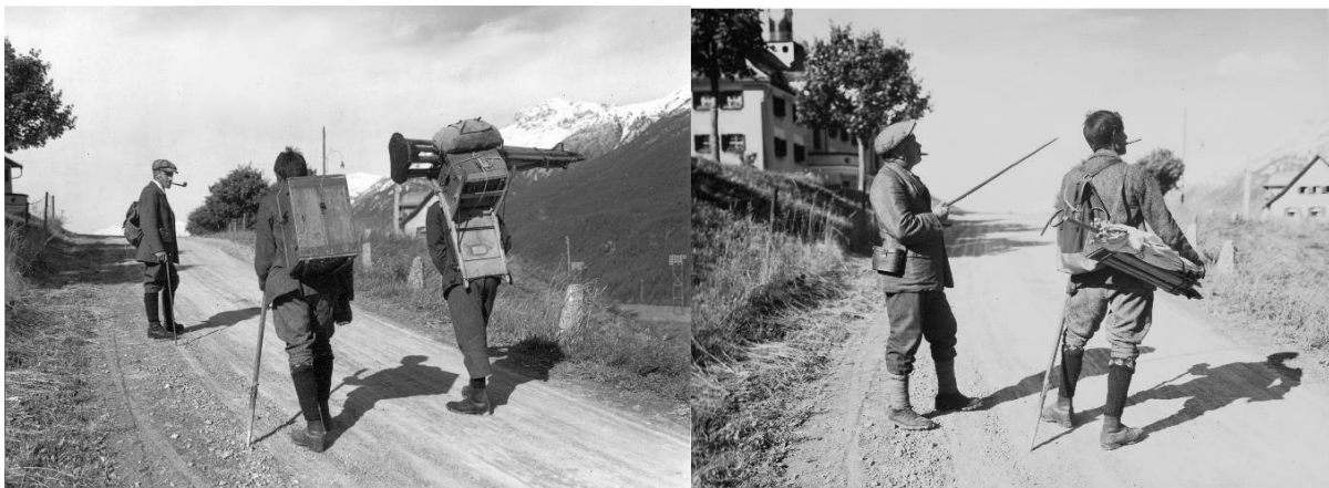
Abb. 3: Die Ausrüstung des Schrauben-Mikroskop-Theodoliten wiegt total 49 kg und muss von 2 Gehilfen getragen werden. Die Wild'sche Ausrüstung dagegen ist nur 17 kg schwer und kann von einem Mann leicht getragen werden.
